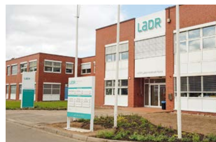
LADR Laborzentrum Nord, Flintbek/Kiel
